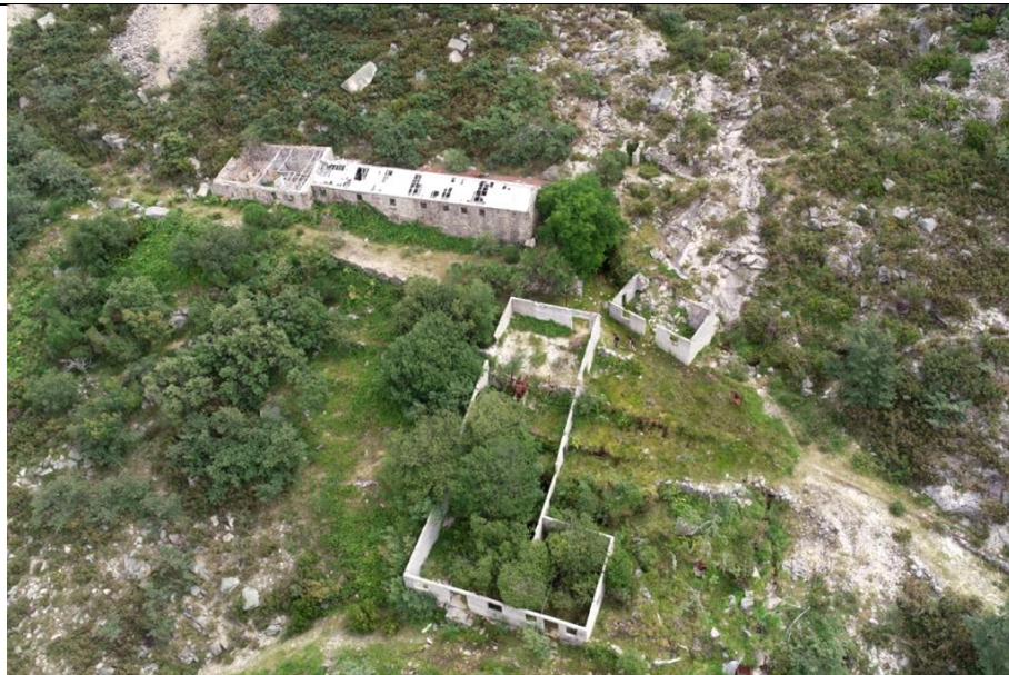
Foto 2. Edificios abandonados da mina. Na parte superior esquerda o edificio de vivendas e servizos e o edificio en "L" que inda conserva a antiga machacadora de mandíbulas e a saída dos raís cara a entulleira.
