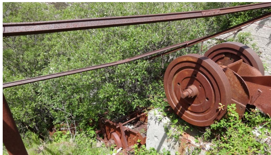
Foto 5. Maquinaria abandonada no edificio de beneficio mineiro. Arriba machacadora de mandíbulas de debaixo criba vibratoria.
